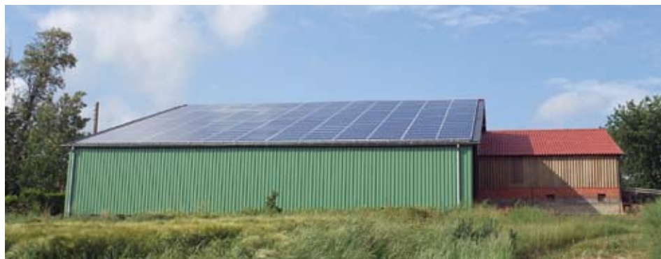
Coup double : la chaleur produite sous les panneaux solaires photovoltaïque posés sur la toiture de cette grange agricole est récupérée pour sécher les fourrages stockés à l'intérieur. Une première pour Solagro et pour Midi-Pyrénées.
