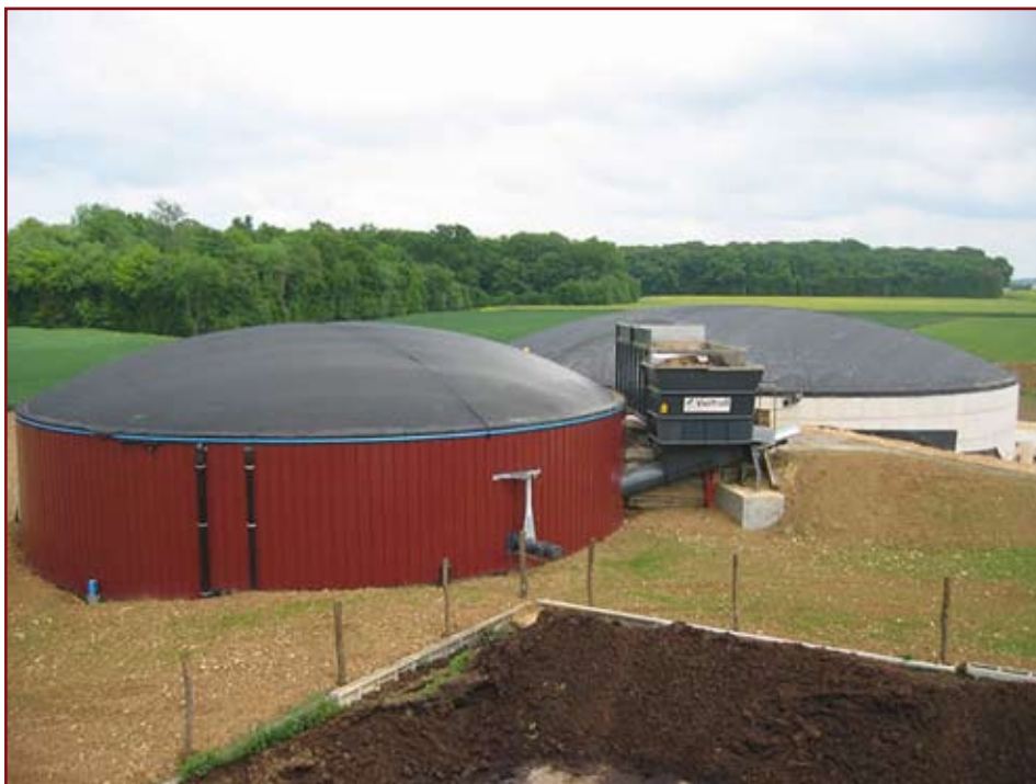
L'unité de méthanisation du GAEC Beets, dans le Loiret - L'électricité produite à partir de biogaz est achetée par EDF, et la chaleur co-générée chauffe les bâtiments d'élevage, les habitations, et maintient à la bonne température le digesteur. Etudes de faisabilité réalisées par Solagro.
